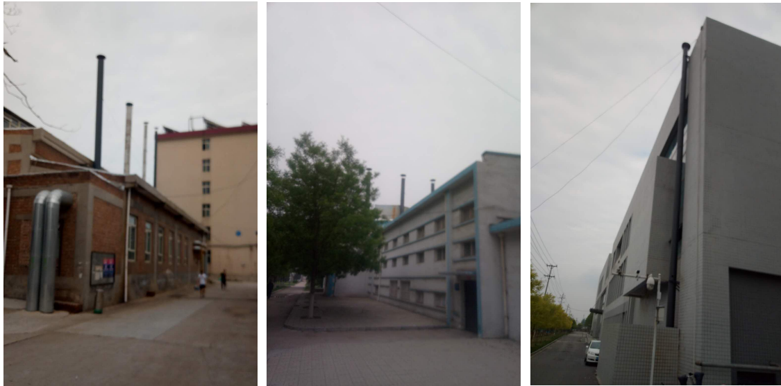
锅炉烟气排气筒
